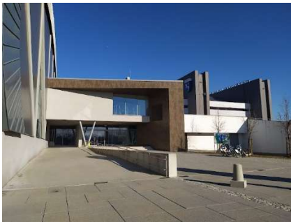
Widok na główne wejście
